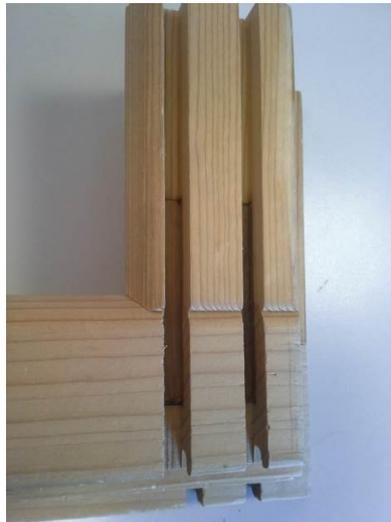
**Abb. 66:** Querschnitt eines Fensterdetails von M SORA mit Dübelverbindung und sichtbaren Dübeln
