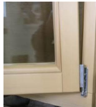
**Abb. 34:** Ausheben des Flügels
