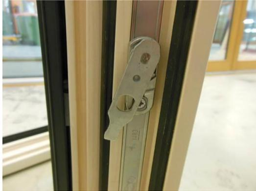
**Abb. 40:** So bringen Sie die Niveauschutzvorrichtung in die vertikale Lage.
