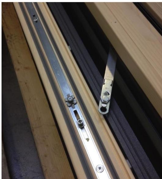
Abb. 50: Aushaken der Schere durch Hochziehen
