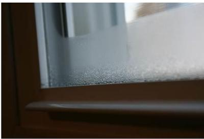
**Abb. 61:** Kondenswasser auf der Innenseite der Fensterscheibe
