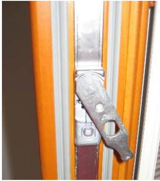
Bereits in der Standardausführung haben die Beschläge eine Sicherung, die das gleichzeitige Öffnen des Fensters auf horizontaler und vertikaler Ebene verhindert.
